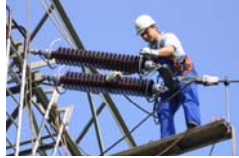
Arbeiten an einer Hochspannungsleitung
