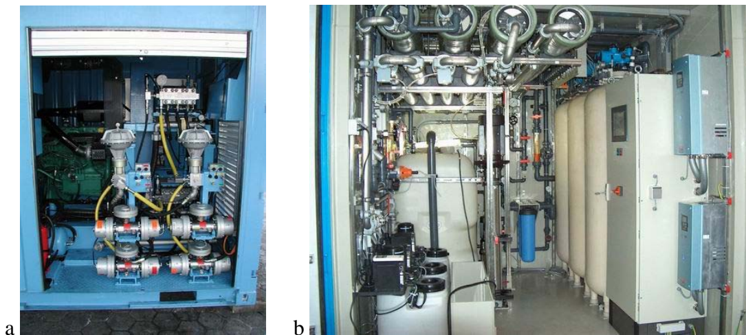
Bild 2. Geräte für das UHPAB-Verfahren.
