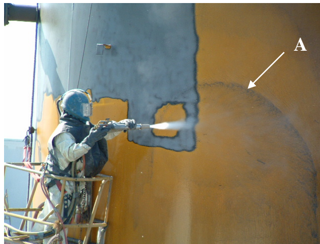
Bild 5. UHPAB-Bearbeitung einer Oberfläche (keine Staubbildung).
