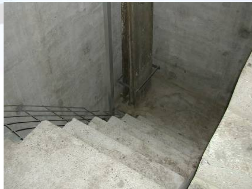
Sauber gereinigte und gestrahlte Betonbeläge nach dem Trockeneisstrahlen
