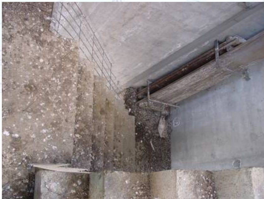
Reinigung der Betonbeläge während einer Betoninstandsetzung
